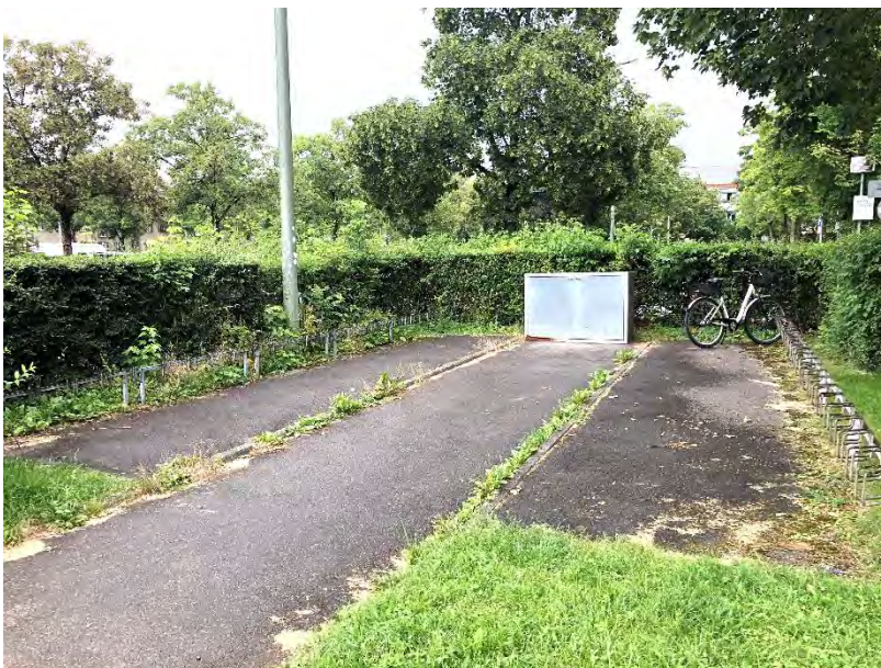
Abbildung 44: Abseitsgelegene Fahrradabstellanlage an der Park+Ride Anlage Michaelibad (Eigene Aufnahme)
