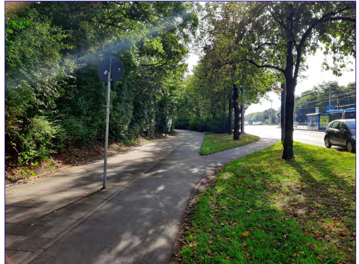
Blickrichtung Osten Einrichtungsradweg stadtauswärts Richtung Westen
