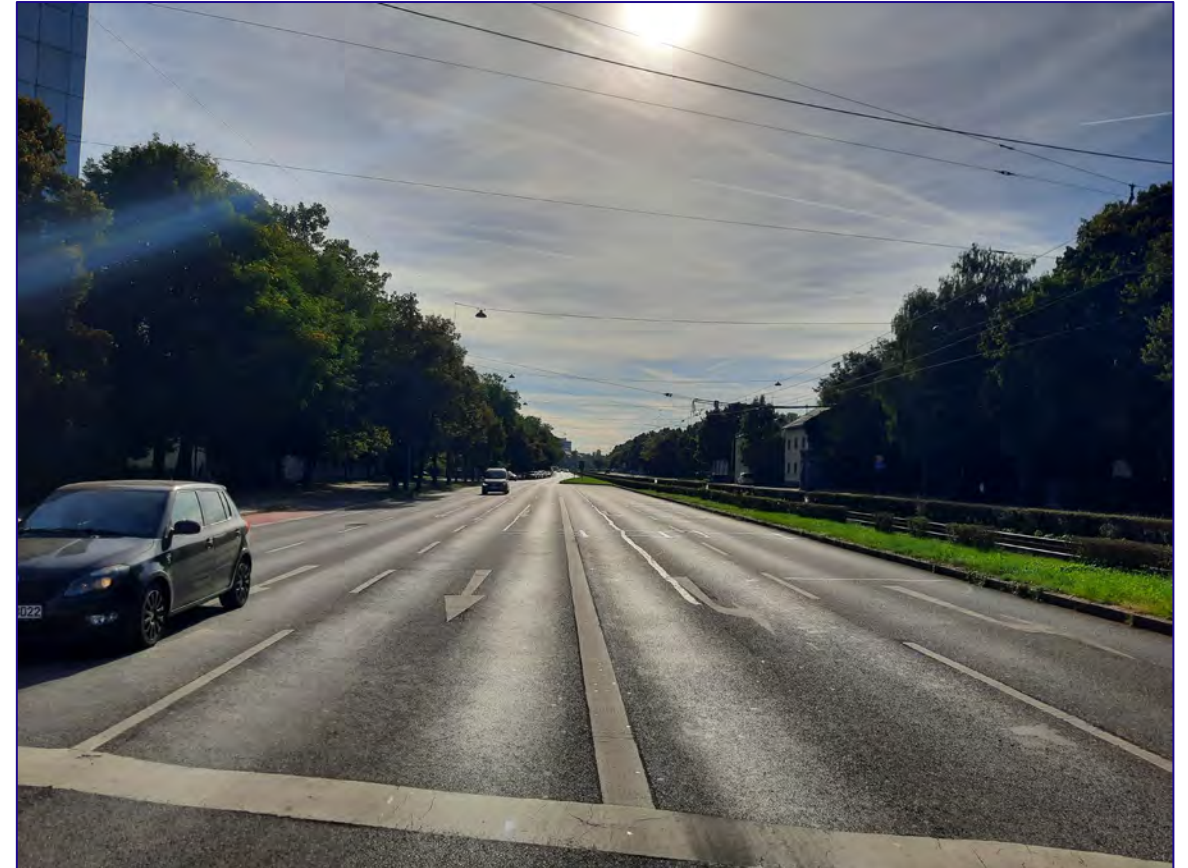
Blickrichtung Südosten Zufahrt Dachauer Straße
