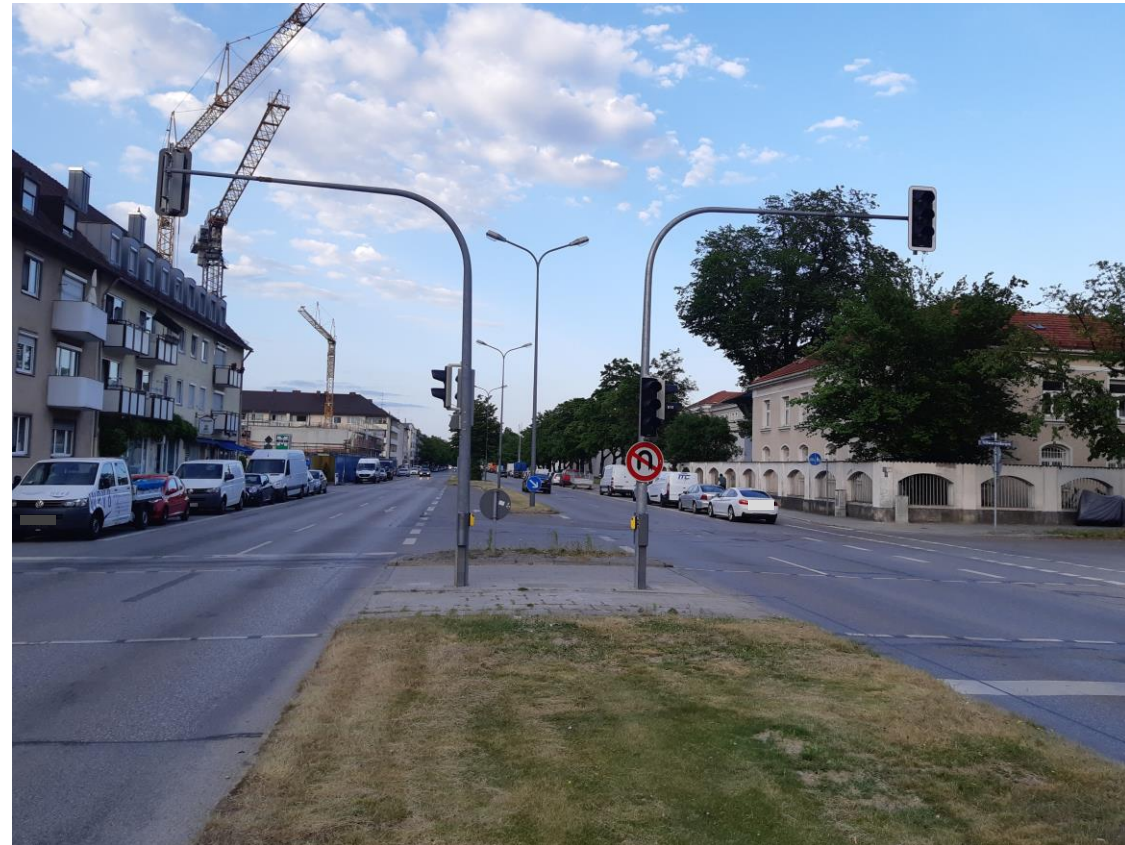
Fußgängerschutzanlage Stadelheimer Straße
