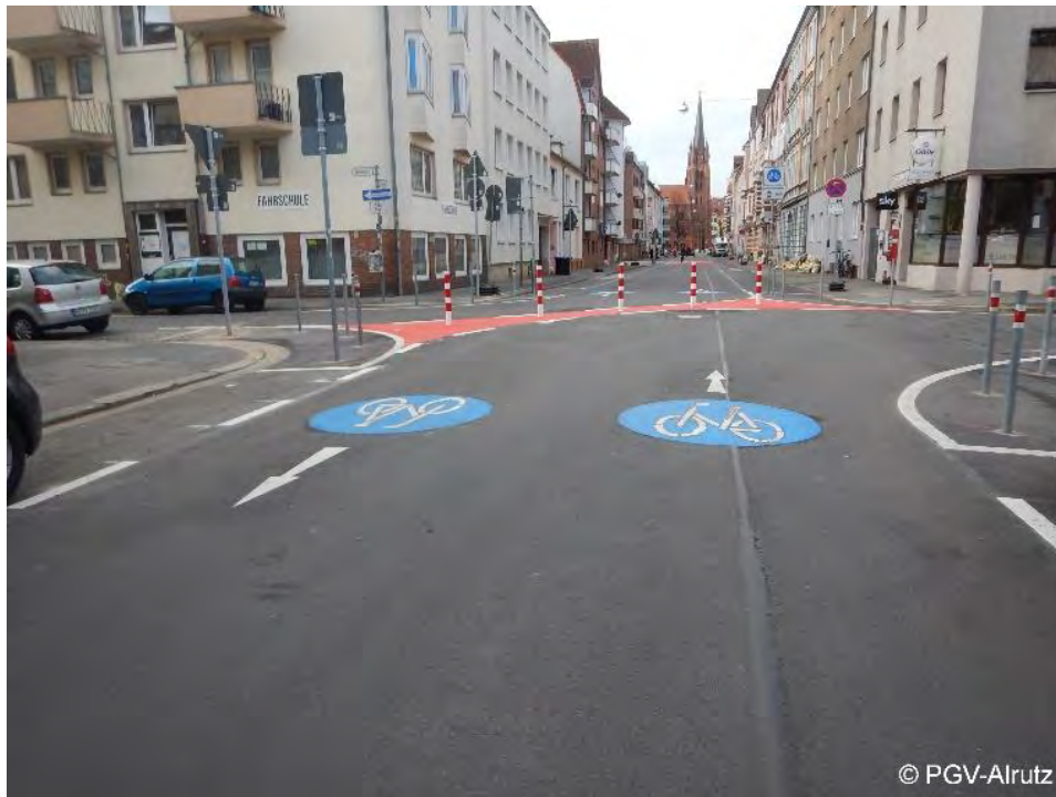
Abb. 5-5: Für Fuß- und Radverkehr durchlässige Diagonalsperre in durchlaufender Fahrradstraße, Hannover
