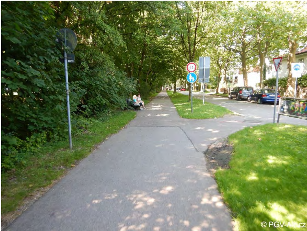
Abb. 5-10: Übergang vom gemeinsamen Geh- und Radweg Canalettostraße zur Fahrbahn Canalettostraße: verdichtete Flächen beidseits der befestigten Fläche weisen auf eine unzureichende Breite des befestigten Weges hin. Radfahrende Richtung Westen sind wartepflichtig gegenüber sehr geringem Kfz-Verkehr aus der und zur Ponzonestraße.
