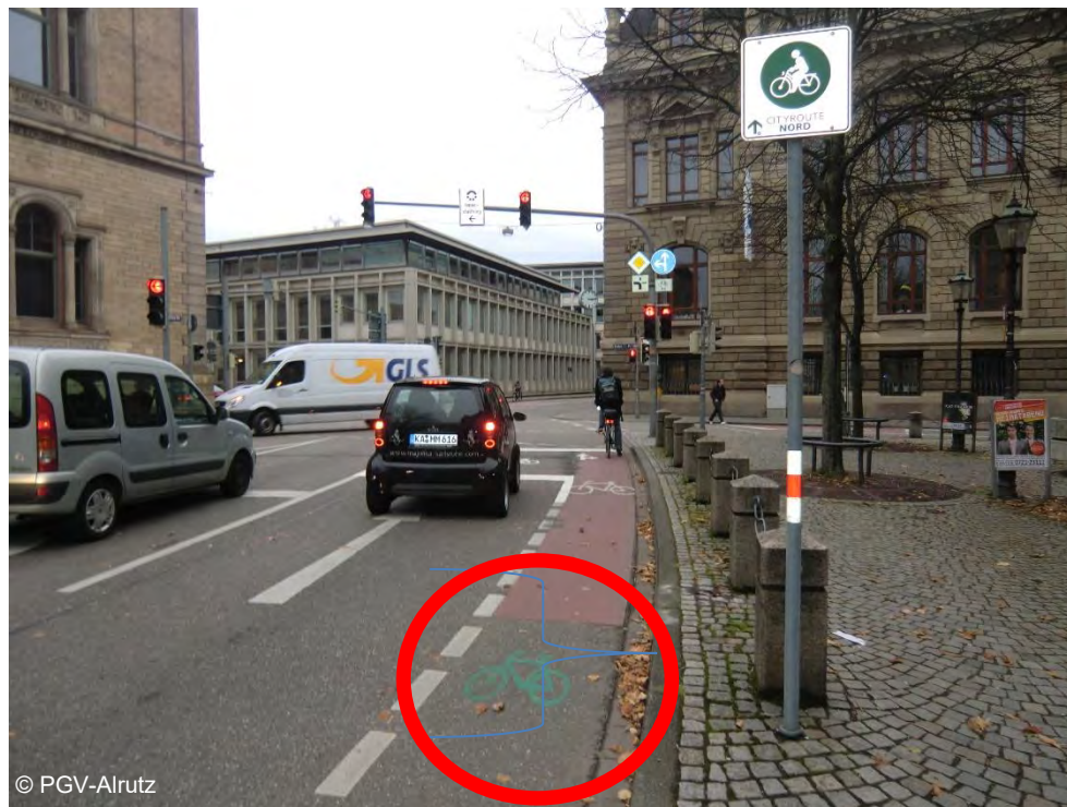
Abb. 5-9: Verdeutlichung der Routenführung mit zusätzlichen farbigen Fahrrad-Piktogrammen, vereinzelt mit Richtungspfeilen ergänzt (Karlsruhe)
