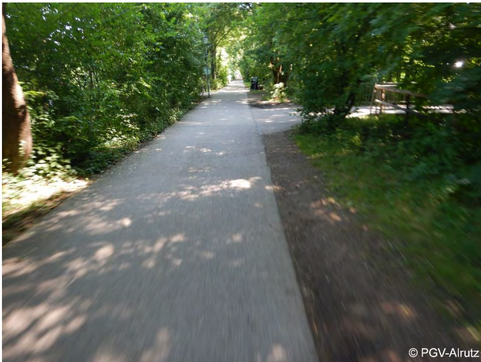
Abb. 5-12: Einmündung des Wegs über die Kanalbrücke zur Böcklinstraße/Demollstraße: Sichtbehinderung durch Gebüsch, hier formal mit Rechts-vor-Links-Regelung
