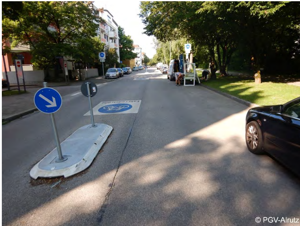
Abb. 5-18: Birnauer Straße: die Inseln haben sich bewährt und sollten dauerhaft eingebaut werden.
