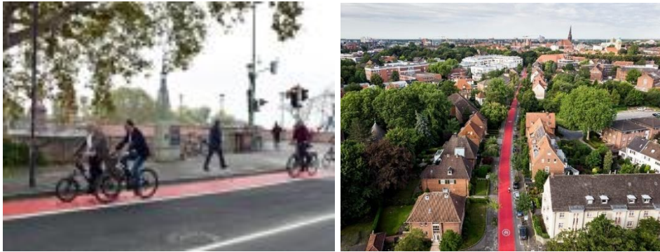
Abb. 2-12: Gestaltung Radfahrstreifen mit streckenhafter flächiger Roteinfärbung (Schöne Aussicht in Frankfurt am Main, Quelle: www.Frankfurt.de )
