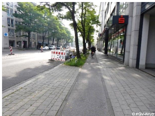
Abb. 3-4: Briener Straße Nordseite, vorher
