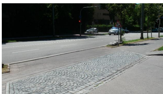
Abb. 3-9: Ausfahrt von Tankstelle Allguth in die Chiemgaustraße Ost Nordseite, vorher (Foto: Viktor Goebel, KVR)
