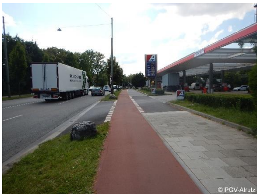
Abb. 6-17: Zufahrt Chiemgaustraße Ost, Nordseite, Richtung Westen
