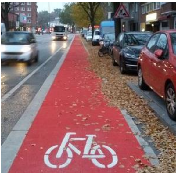
Abb. 2-11: Radfahrstreifen entgegen Einbahnstraße in der Hamburger Hufnerstraße mit dahinter liegenden Parkständen und zuvor häufigem Falschparken auf dem Radfahrstreifen (Quelle: KUPKE 2018)
