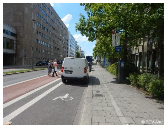
Abb. 3-2: Marsstraße Nordseite, nachher
