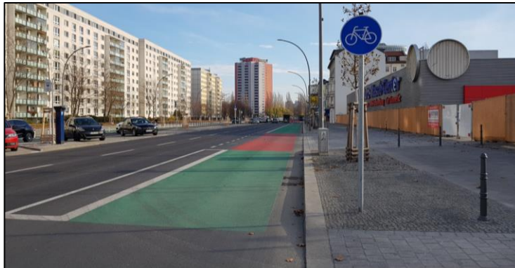
Bild 2-2: Berlin; flächig grüne Markierung eines Radfahrstreifens, an einer Konfliktstelle (Grundstücks-zufahrt) dagegen rote Einfärbung (Quelle: PGV-Alrutz)
