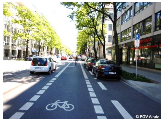
Bild 1-4: Briener Straße Nordseite, nachher
