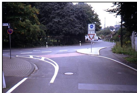
Bild 3-16: Einengung eines Knotenpunktes am Beginn einer Fahrradstraße (Herford)
