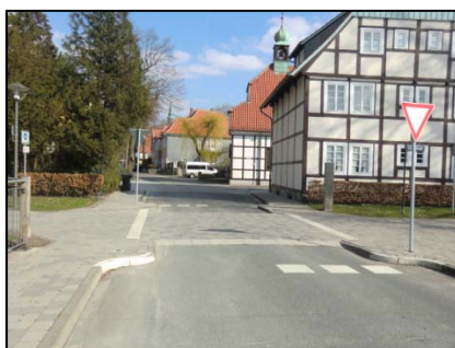
Bild 3-15: Fahrradstraße mit Bevorrechtigung am Knotenpunkt, mit Aufpflasterung. Die Fahrradstraße wird allerdings vor dem Knotenpunkt aufgehoben und nach dem Knotenpunkt wieder ausgewiesen (Rietberg).
