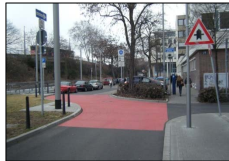
Bild 3-5: Fahrradstraße in Einbahnstraße für den Kfz-Verkehr, mit Bevorrechtigung am Knotenpunkt, allein mit Beschilderung und Markierung (Mannheim)
