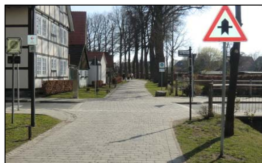
Bild 3-15: Fahrradstraße mit Bevorrechtigung am Knotenpunkt, mit Aufpflasterung. Die Fahrradstraße wird allerdings vor dem Knotenpunkt aufgehoben und nach dem Knotenpunkt wieder ausgewiesen (Rietberg).
