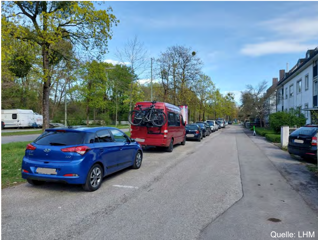
Anliegerfahrbahn – Blick nach Osten
