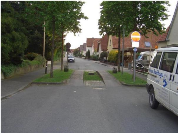
**Abb. 8-1: Fahrrad- und Busschleuse (Lemgo) als möglicher Lösungsansatz für die Zufahrten zur Hackerbrücke**
