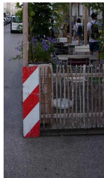
Abbildung 8 Absicherung mit Leitplatten Foto: Green City e.V., Frese
